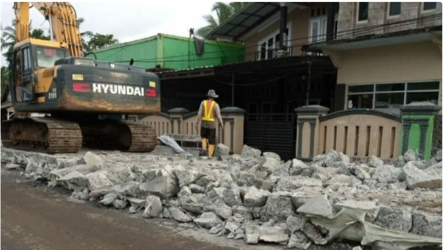
Pembangunan Cor Beton Jalan nasional Simpang-Bayah dibongkar
